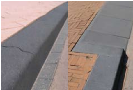
brede trottoirbanden waar sprake is van hoogteverschil
