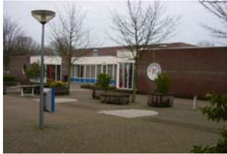
gebouw 'In Den Herbergh' blijft bestaan
