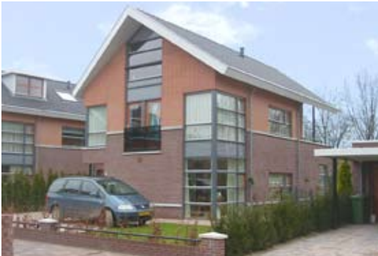
vrijstaande woning met opengewerkte hoek en overdekt terras aan achterzijde
