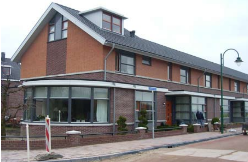
kopgevels voorzien van erkers
