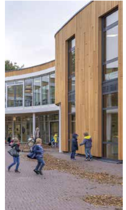
Verticale geleding in de gevel
